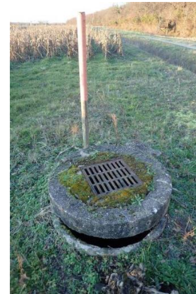
Photo 2 : Drain agricole identifié sur site
